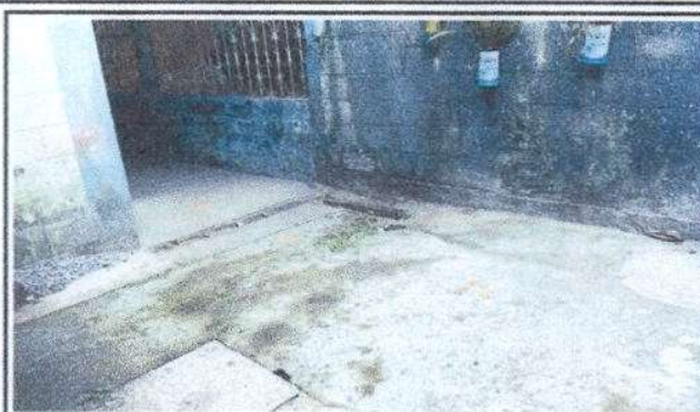
Foto 8: Reparación de planchas de concreto de patio
