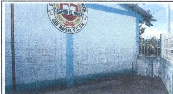
Foto 3: Pintura en muros exteriores
