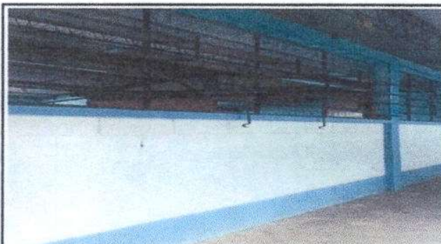
Foto 12: Sustitución de estructura de metal de ventana
