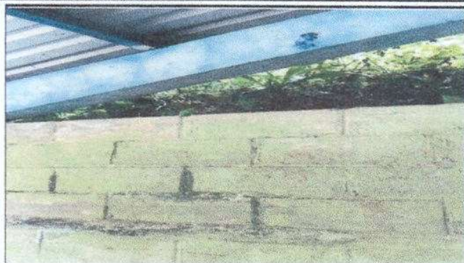
Foto 7: Reparación de muro de contención
