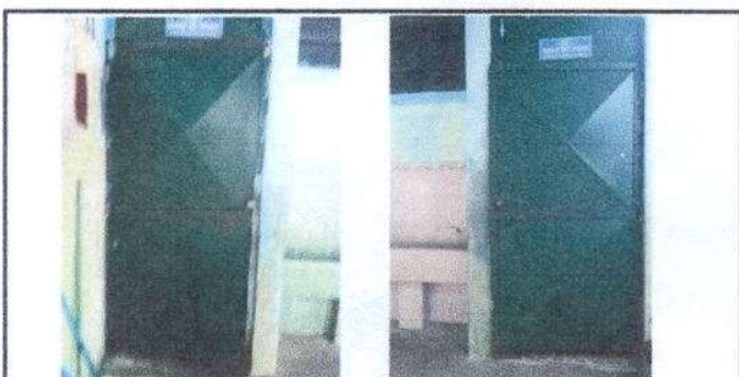
Foto 6: Sustitución de puerta en servicios sanitarios con su chapa YALE
