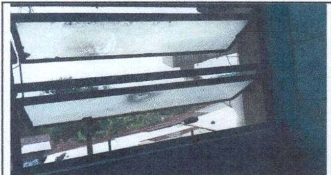
Foto 4: Sustitución de estructura de metal de ventana
